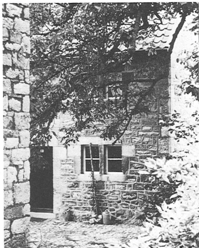
885. RIESSONSART, 64. Façade du logis.
