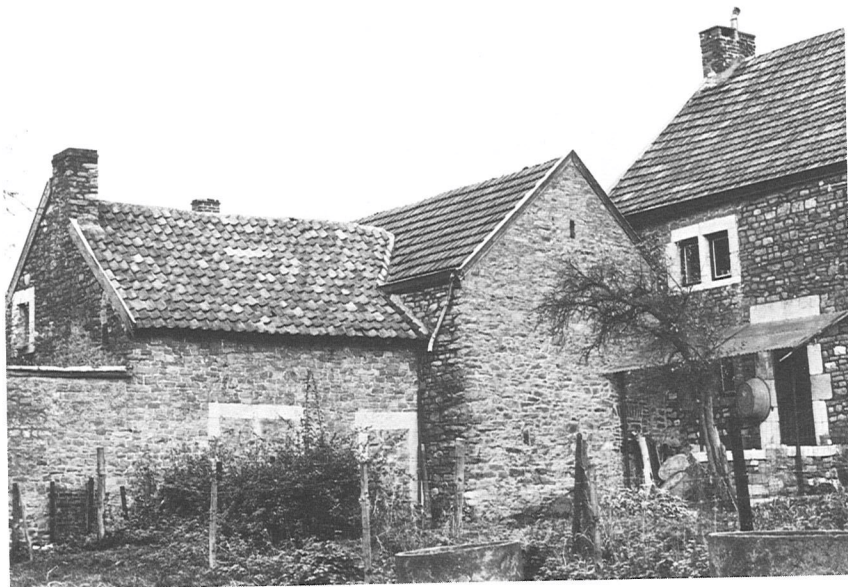
814.HANSEZ. Village, 50 et 51. Façades postérieures et fournil.
