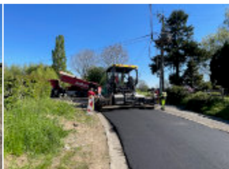
Après le renforcement du réseau électrique par Resa, réfection complète d'une partie de la voirie rue de Hansez
