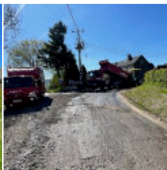
Après le renforcement du réseau électrique par Resa, réfection complète d'une partie de la voirie rue de Hansez
