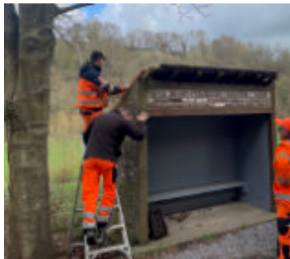
Restauration des toitures de l'ensemble des abris bus
