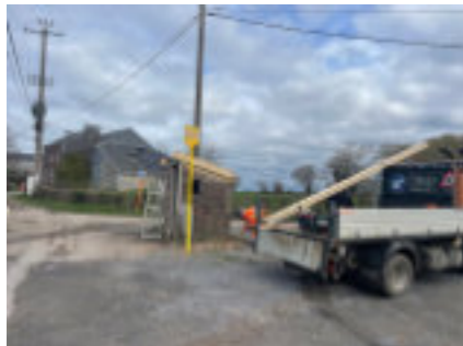
Abris bus - réparations des toitures
