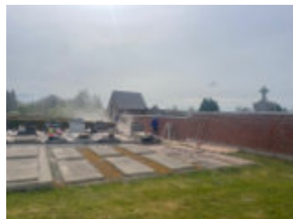
Sablage et rejointoyage du mur arrière du cimetière d'Olné
