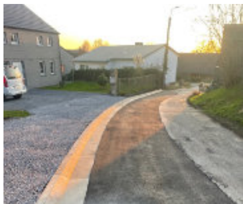
Pose d'un filet d'eau Chemin du cordonnier
