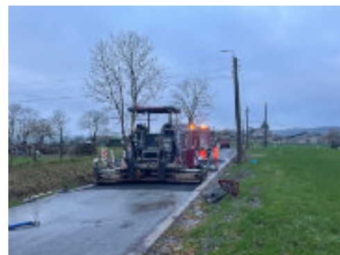
Asphaltage du haut de la rue Herdavoie et du carrefour avec les rues Raffhay et Mitoyenne
