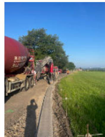
Travaux rue Rafhay
