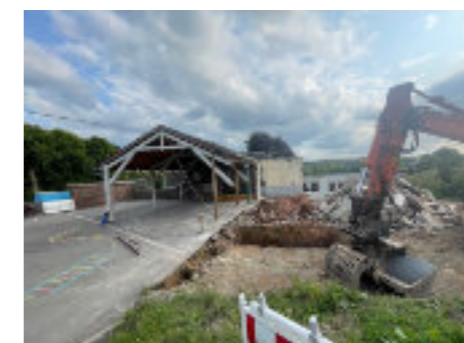
Démolition du bâtiment endommagé à l'école de St Hadelin
