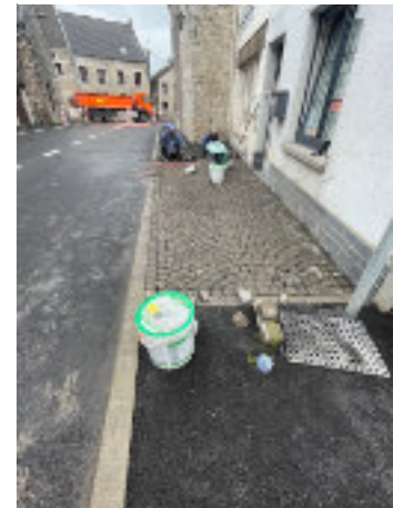
Pavage des trottoirs du bas de la rue Village
