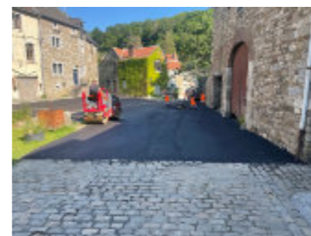
Pose d'asphalte dans le quartier de Petit Vaux, ce qui clôture les travaux de réfection en profondeur
