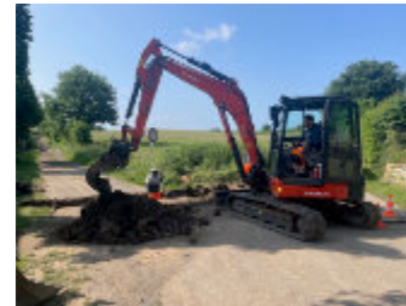
Pose d'un caniveau pour éviter les ruissellements derrière le cimetière de St Hadelin
