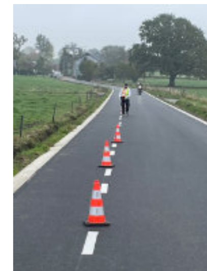
Après l'asphalte, marquage au sol rue Raffhay (chaussée à voie centrale)
