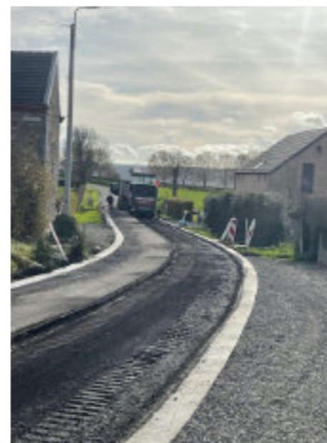
Travaux de raclage et préparation avant la pose d'asphalte sur la rue Herdavoie, le carrefour avec la rue Raffhay et le début de Martinmont
