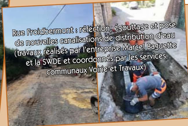
Rue Froidbermont : réfection, égouttage et pose de nouvelles canalisations de distribution d'eau (travaux réalisés par l'entreprise Marcel Baguette et la SWDE et coordonnés par les services communaux Voirie et Travaux)
